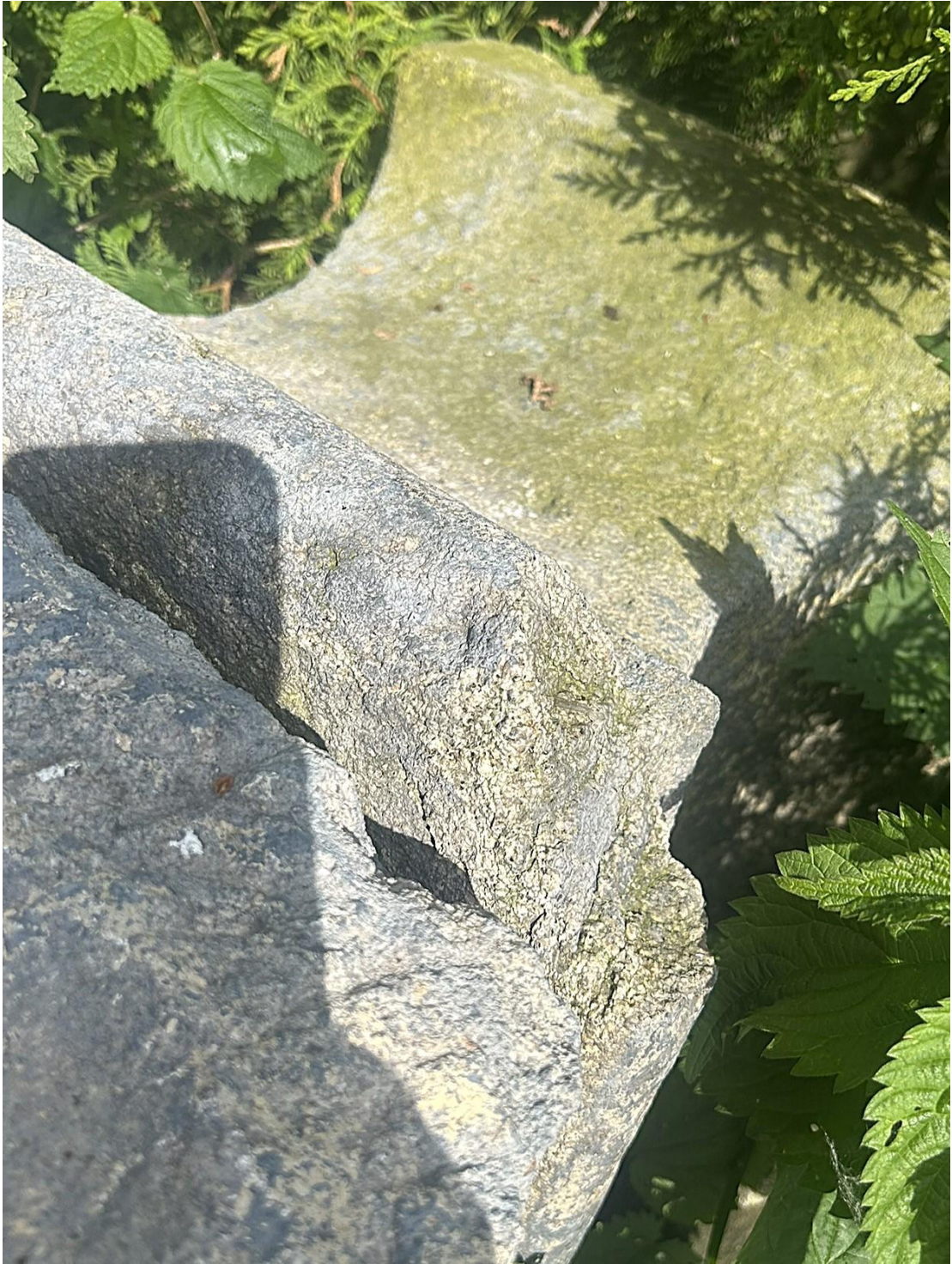
Fragment obiektu- ubytek i pęknięcie na cokole
