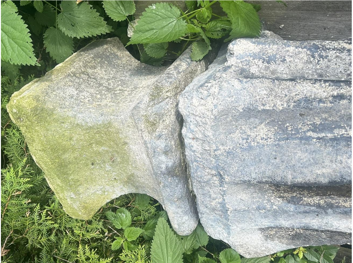
Widoczne nawarstwienia i drobne ubytki
