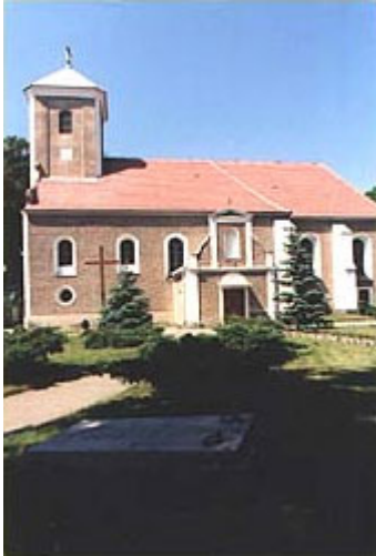
Mroczkowa - kościół odpustowy p.w. NPM Wspomożycielki, murowany z XIX w.
